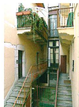
Élévation latérale. Les escaliers.
