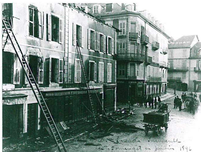
Incendie de l'immeuble Louis Domenget, place Carnot en janvier 1896.
