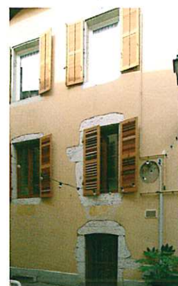
Détail de l'élévation
