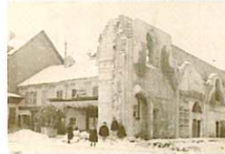
Démolition de l'ancienne église, début XXe siècle.
