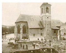
Creusement des fondations de l'hôtel Astoria, 1905
