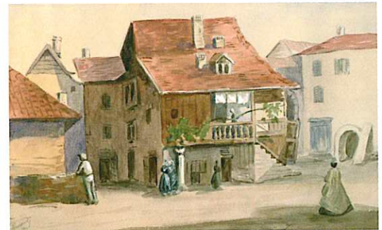
La maison de Blanc Henriette, démolie en 1850, place des Bains romains. Aquarelle de Pernoud, 1919
