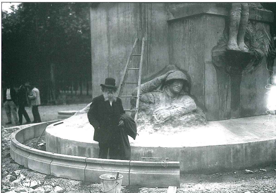
Alfred Boucher pendant la construction du monument aux Morts d'Aix-les-Bains (Photo Edouard Navello - Société d'Art et d'Histoire)
