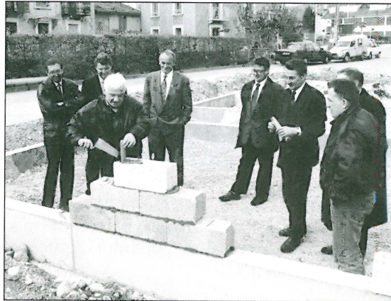
◀ Pose de la première pierre du nouveau gymnase par R. Deconfin. (1992)
