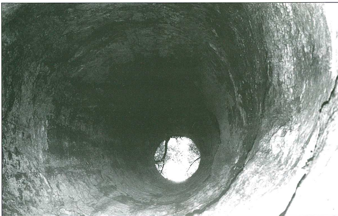
Puit d'extraction à proximité de la voie ferrée.
