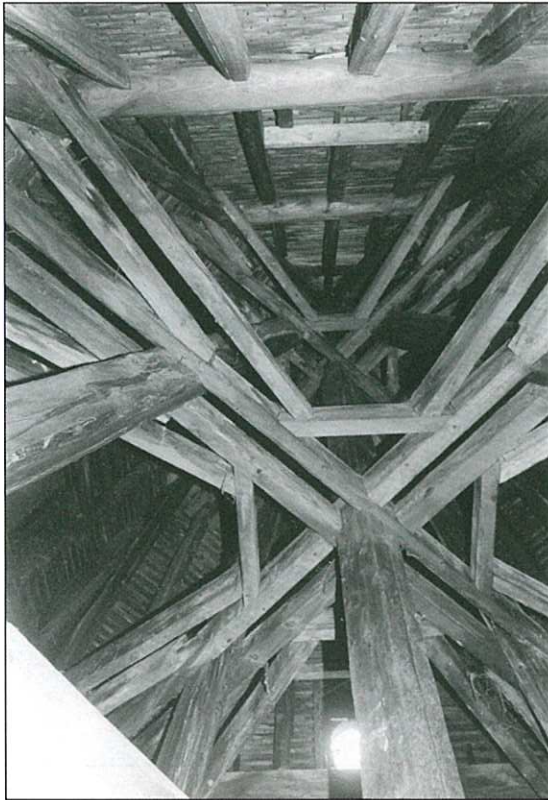
Charpente du clocheton de la tour centrale
