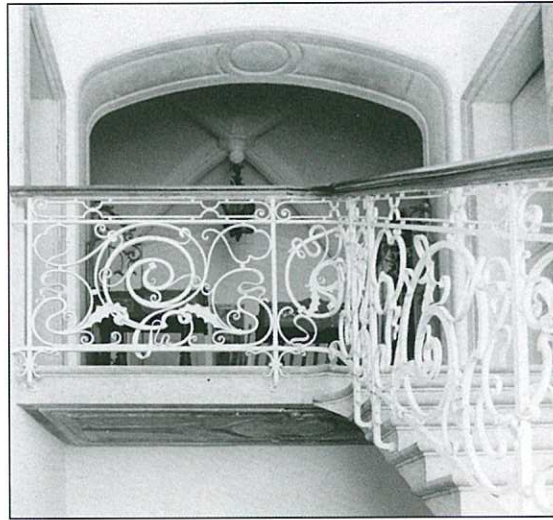
L'escalier photographié en 1994
