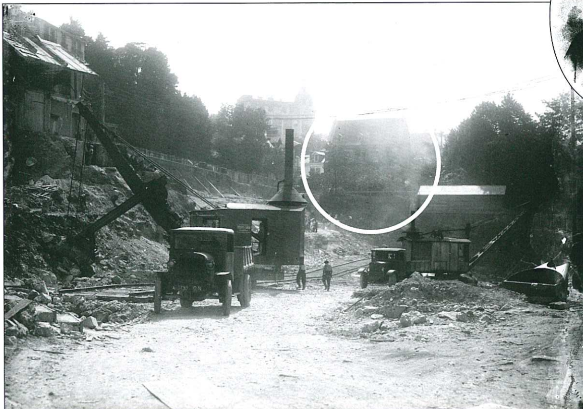
Chantier de construction des Thermes Nationaux. Dans le cercle, l'Asile Évangélique qui va être démoli.
