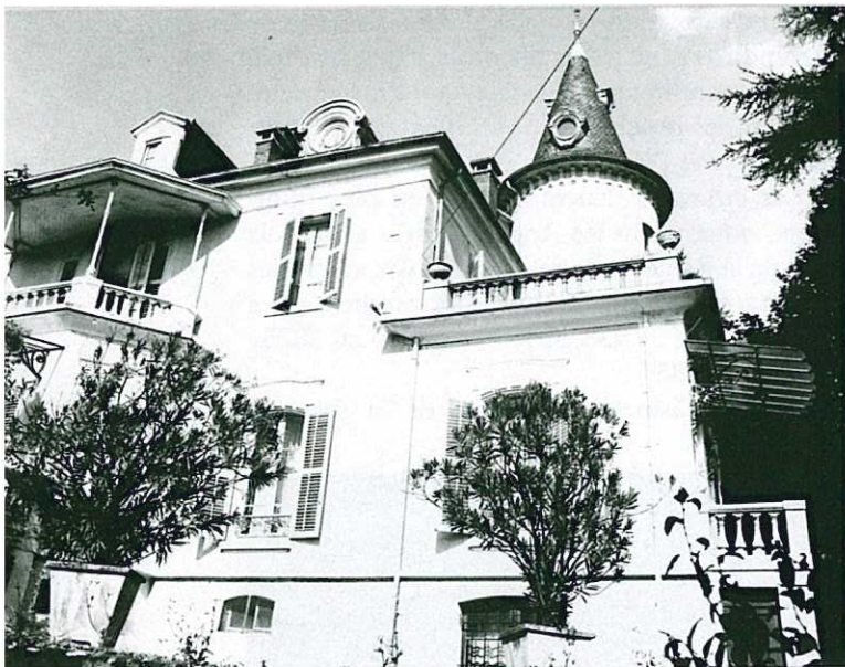
La Villa Saint Christophe, bd des Côtes. Démolie en 1978. (Coll. AC Aix-les-Bains)
