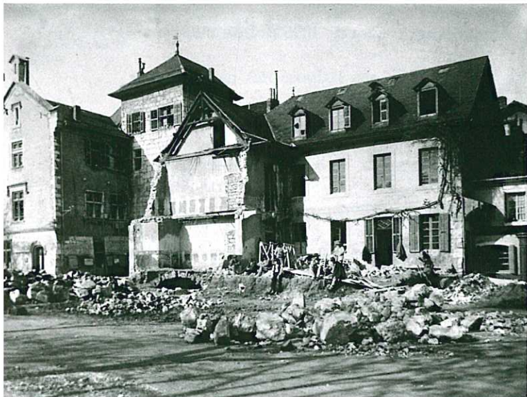
Démolition de l'ancienne école des sœurs de Saint Joseph. (Coll. AC Aix-les-Bains)
