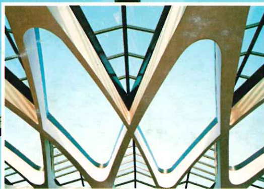
Satolas Couverture des quais de la gare TGV.
