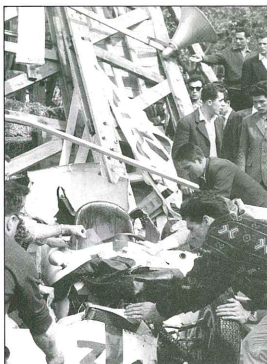
1960 : L'accident après l'effondrement de la passerelle.
