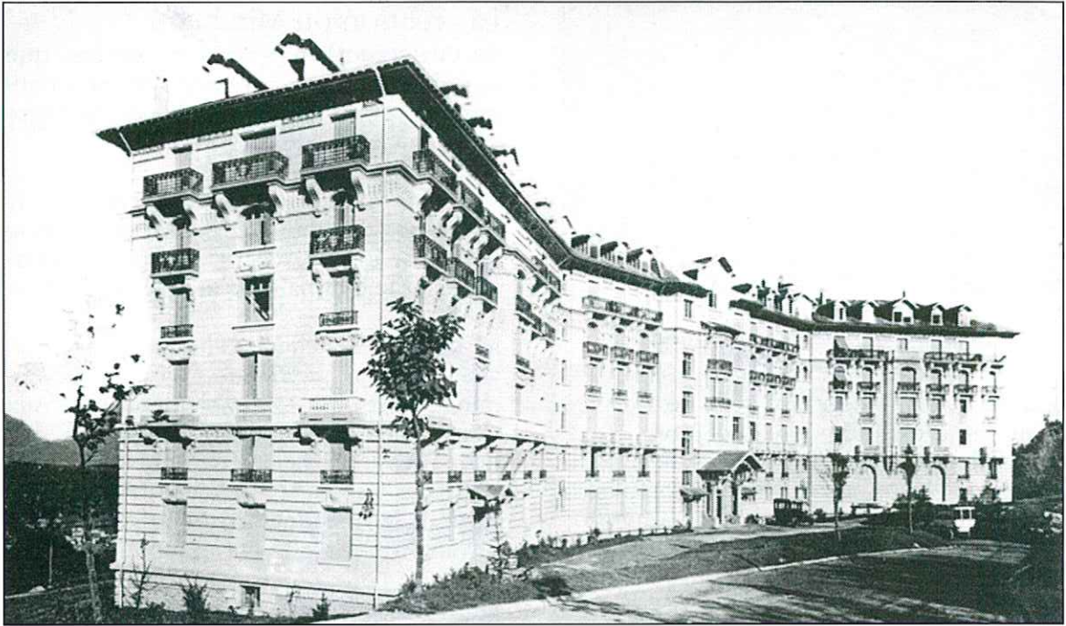
La façade Sud
