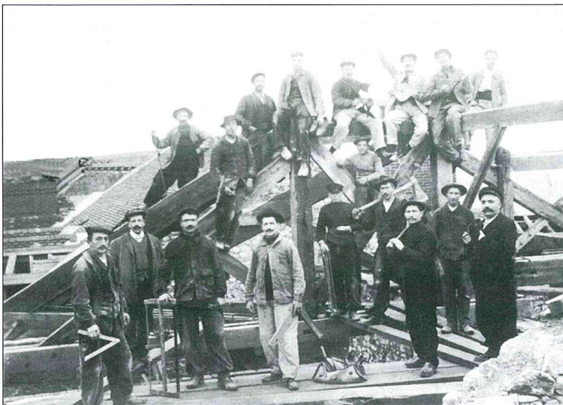
La fin du chantier
